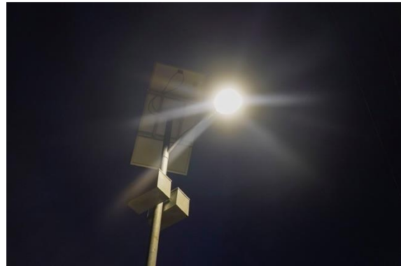
Fotografía 1 Registro de las luminarias instaladas en la localidad de El Tome, con su banco de baterías, panel fotovoltaico y en funcionamiento.
