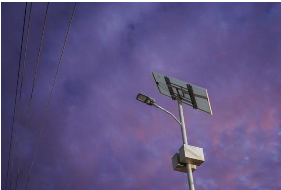
Fotografía 1 Registro de las luminarias instaladas en la localidad de El Tome, con su banco de baterías, panel fotovoltaico y en funcionamiento.
