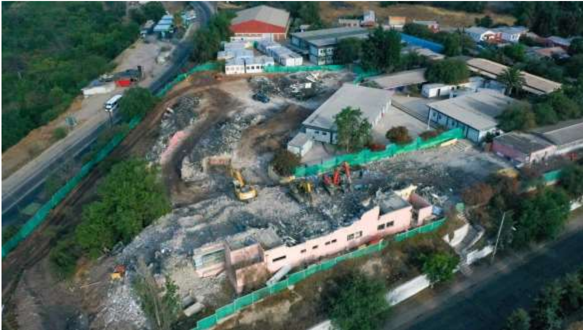
Ilustración 30 Toma área del proceso de demolición previo a la reposición del Liceo Pdte. Eduardo Frei Montalva.
