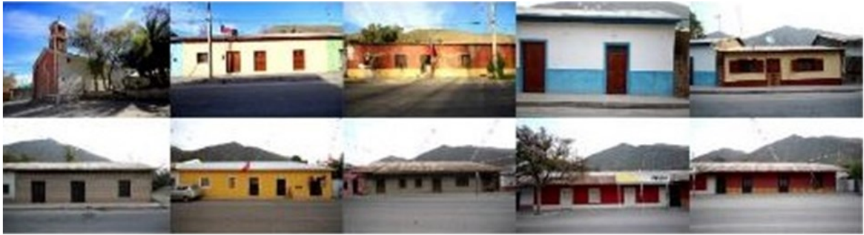
Fig. 7. Edificaciones representativas de la Imagen Urbana de la Localidad de Rapel
