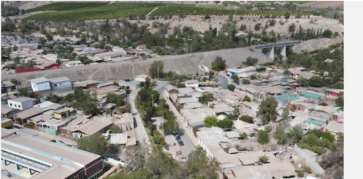
Fig. 49. Paso de la línea férrea y separación de dos poblaciones en Monte Patria
