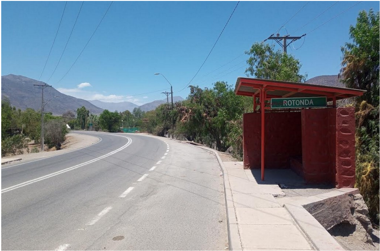
Fig. 40. Paradero de Transporte Público ubicado en la Rotonda de Localidad de Monte Patria
