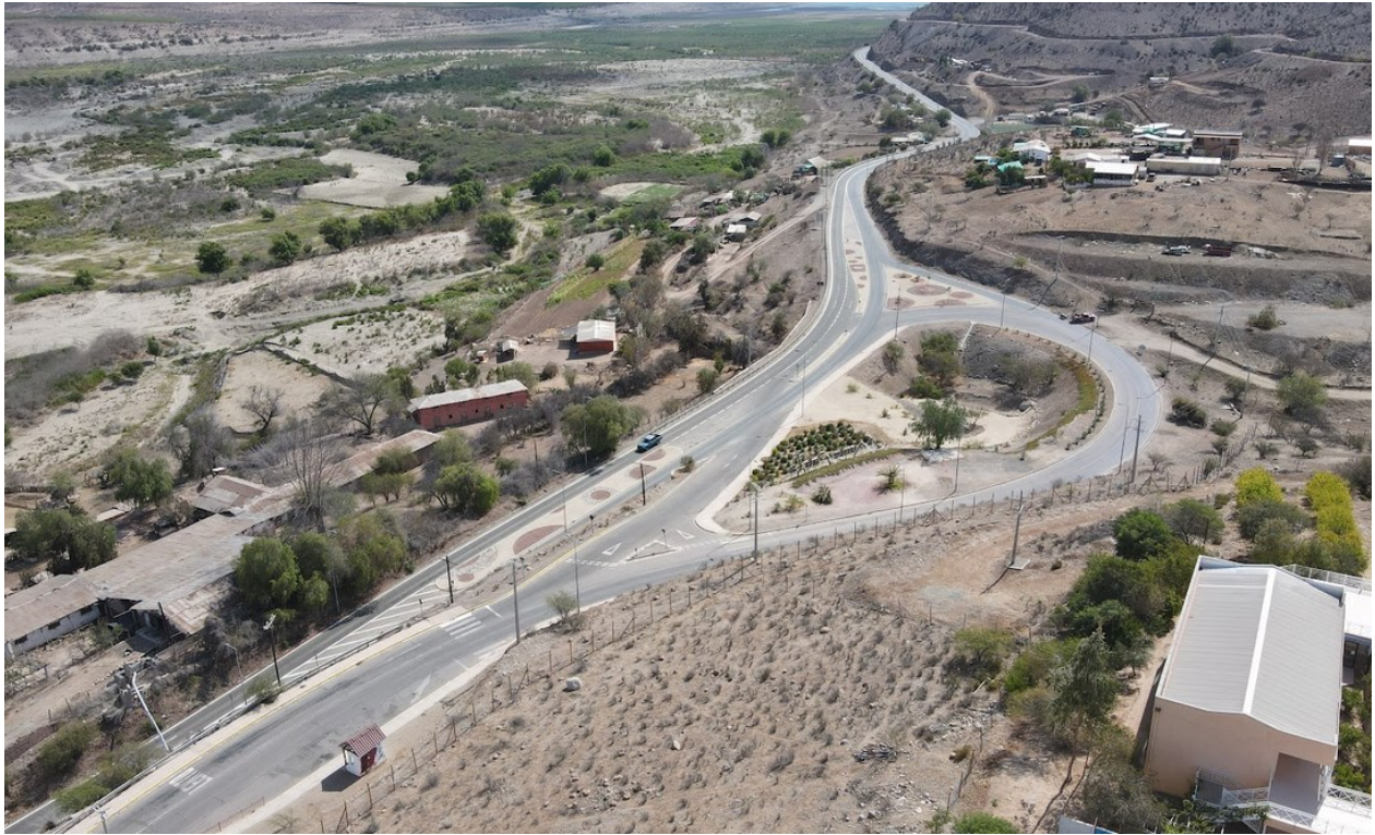
Fig. 38. Enlace vial ubicado en el acceso oriente de la Localidad de Monte Patria Fuente: Archivo fotográfico Consultor, 2022
