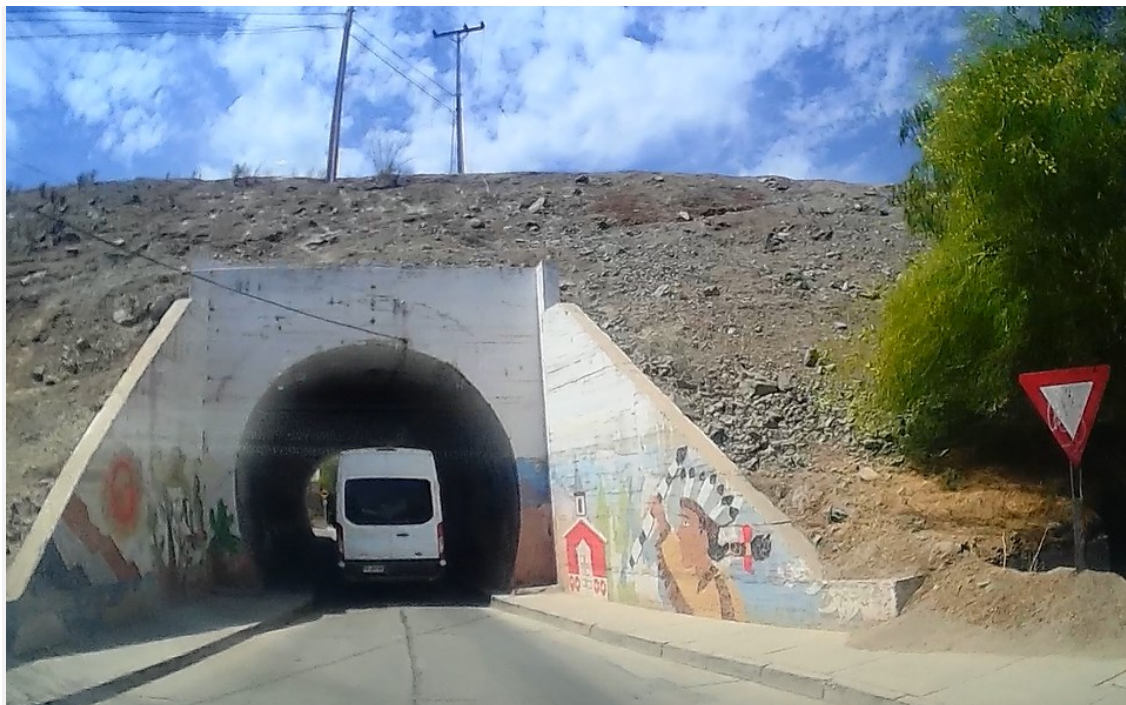
Fig. 42. Túnel vial ubicado en calle Arturo Prat, Localidad de Monte Patria Fuente: Archivo fotográfico Consultor, 2022
