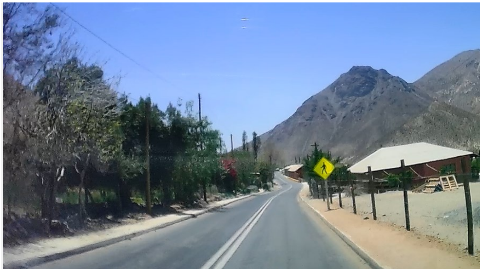
Fig. 7. Ruta D-597 Desde Tuluahuén a Chañaral de Carén Fuente: Archivo fotográfico Consultor, 2022
