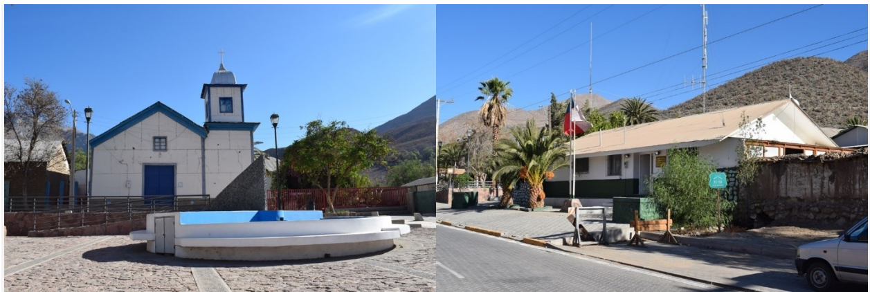
Fig. 43. Equipamiento de culto y seguridad Localidad de Tulahuén
