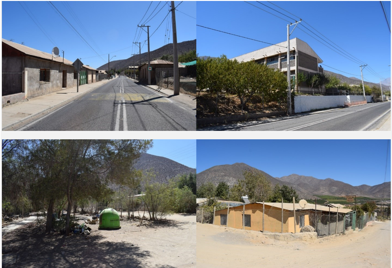
Fig. 26. Residencias y equipamiento educacional sector centro Localidad de Chilecito
