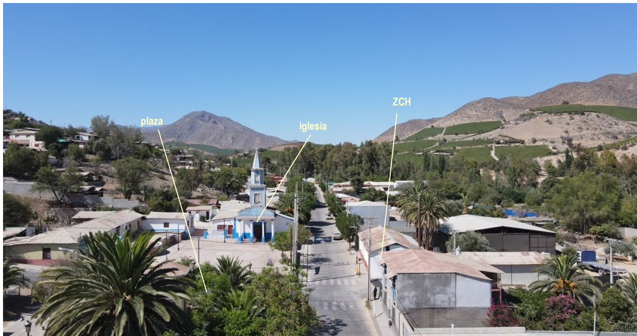
Fig. 21. Conjunto iglesia - espacio público Localidad de Chañaral Alto / Actualización PRC_MPatria
