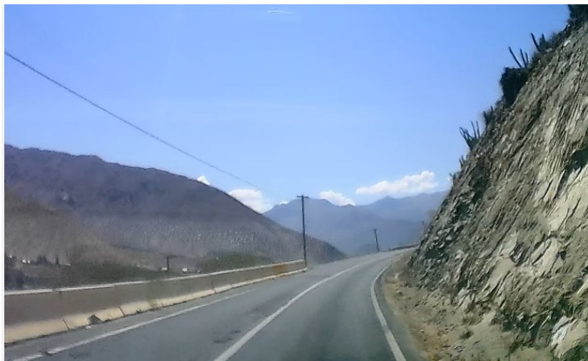
Fig. 5. Ruta D-577 Camino a Pedregal Fuente: Archivo fotográfico Consultor, 2022
