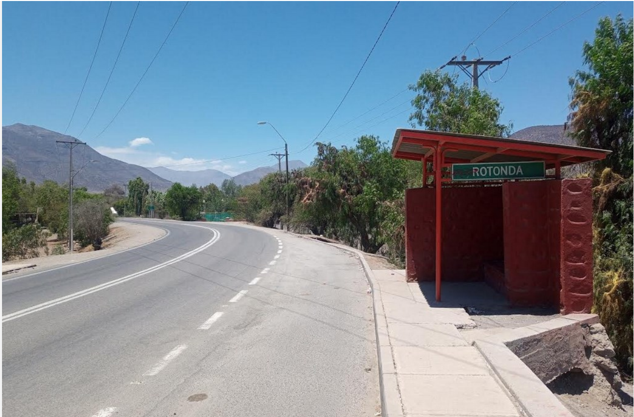
Fig. 38. Paradero de Transporte Público ubicado en la Rotonda de Localidad de Monte Patria
