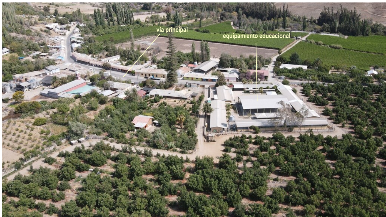
Fig. 49. Estructura urbana Localidad de Rapel / Actualización PRC_MPatria Fuente: Archivo fotográfico Consultor, 2022
