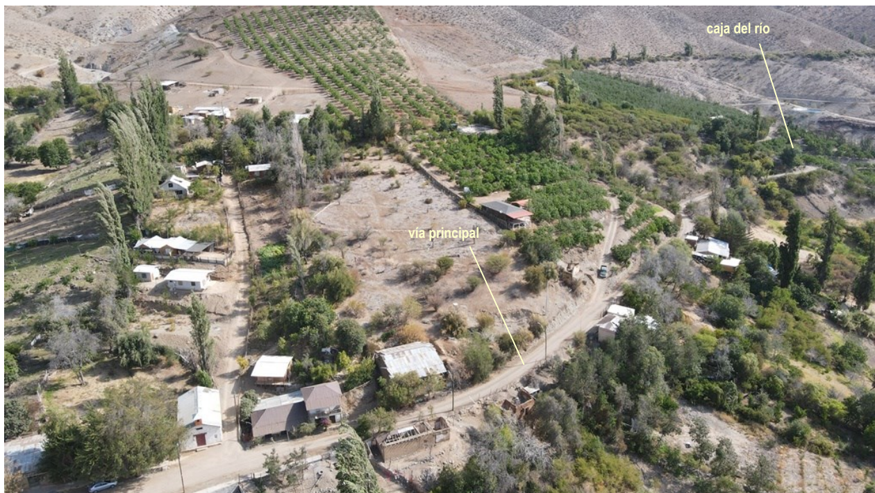
Fig. 53. Relación del área urbana en el contexto próximo Localidad de Las Mollacas / Actualización PRC_MPatria Fuente: Archivo fotográfico Consultor, 2022
