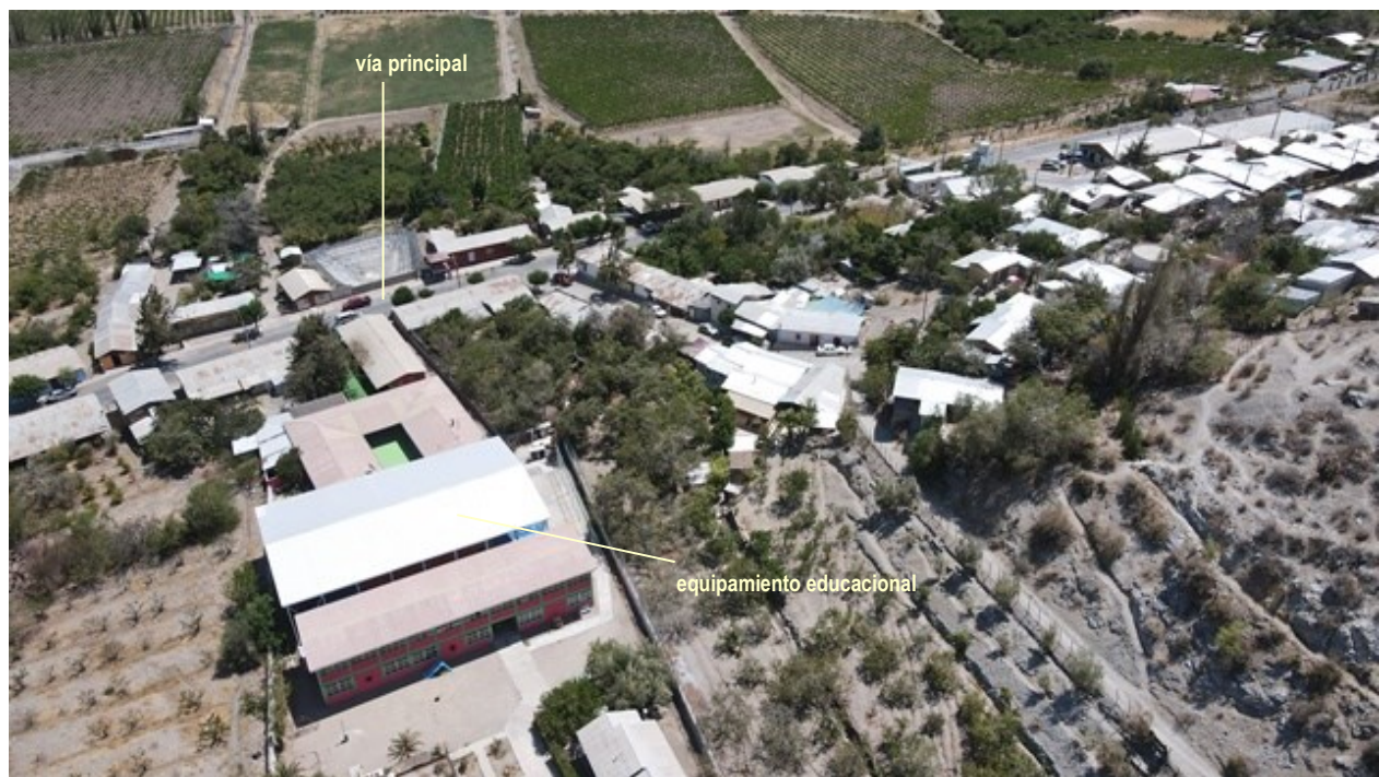
Fig. 45. Tipología de la edificación Localidad de Pedregal / Actualización PRC_MPatria
