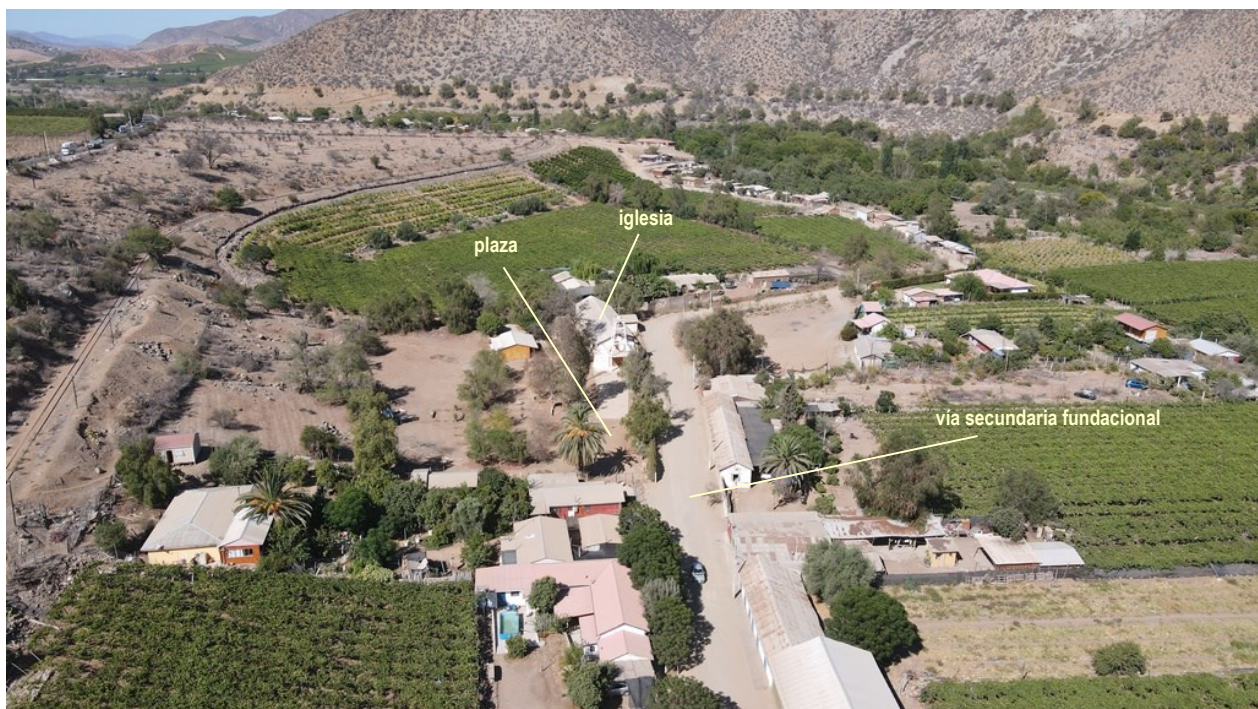
Fig. 17. Conjunto iglesia - espacio público Localidad de Huatulame / Actualización PRC_MPatria Fuente: Archivo fotográfico Consultor, 2022
