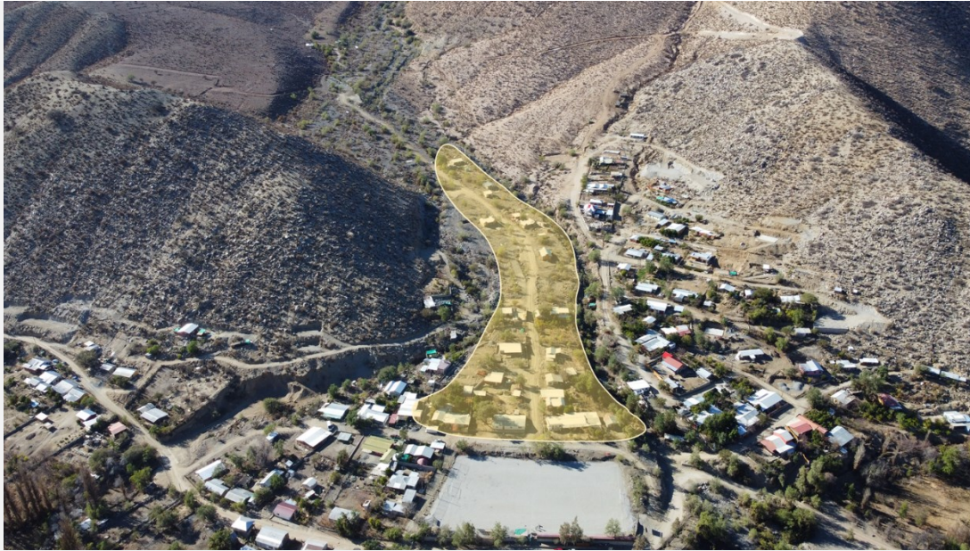
Fig. 32. Crecimiento poblacional no planificado en zona inundable de la Quebrada Cisterna en Tulahuén, Comuna Monte Patria Fuente: Archivo fotográfico del Consultor, 2022
