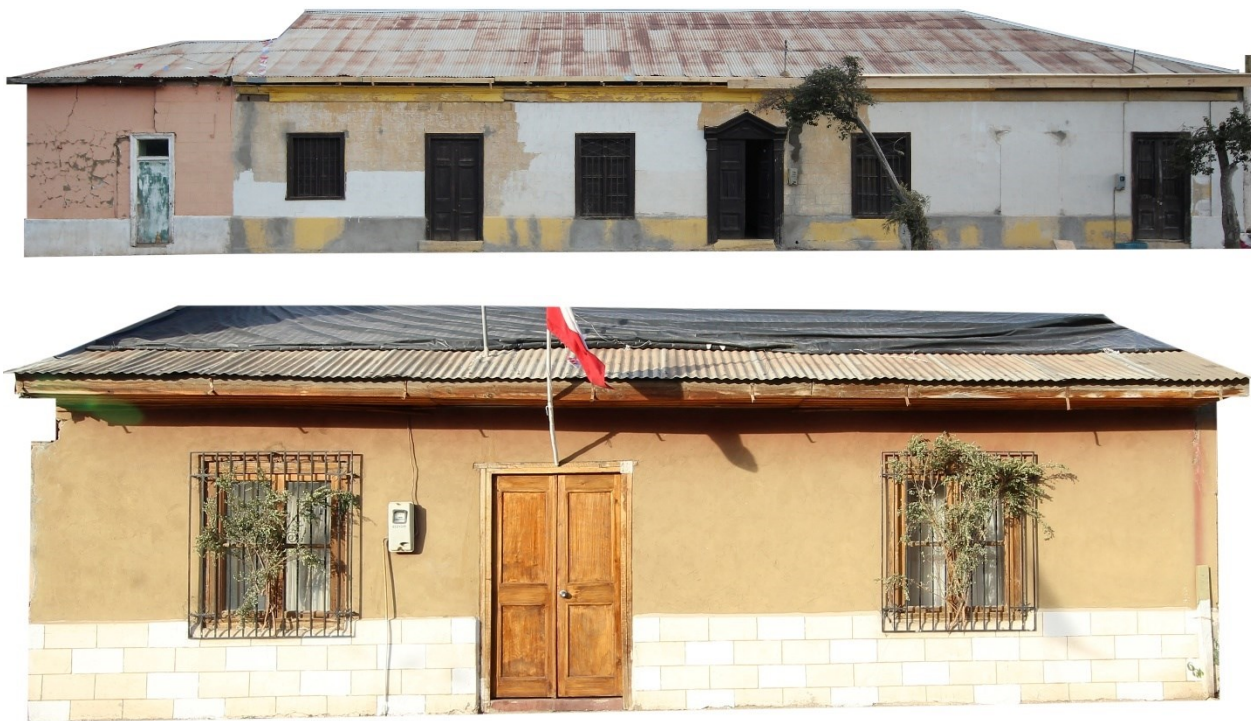
Fig. 16. Tipologías arquitectónicas de la Localidad de Rapel
