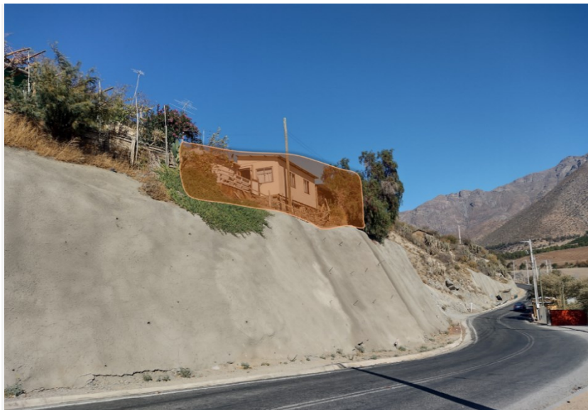
Fig. 26. Viviendas en riesgo ante procesos de ladera en la localidad de Carén, Comuna Monte Patria
