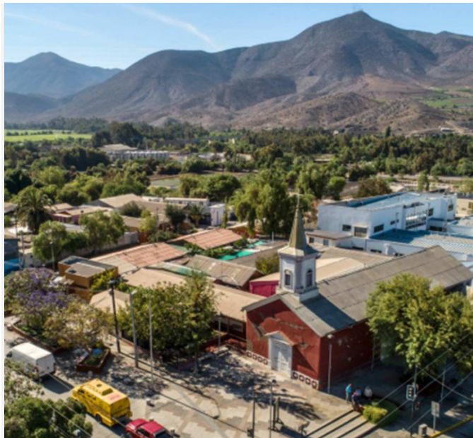
Fig. 36. Iglesia de Monte Patria. Patrimonio cultural en mal estado de conservación
