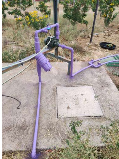
Vista general de Filtros acumuladores bomba y filtro.
