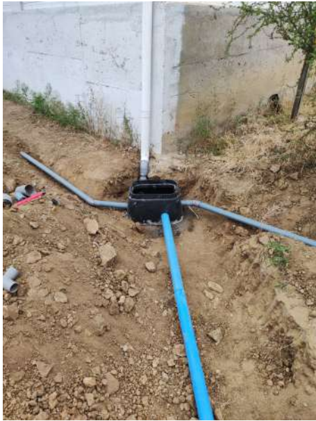
Decantador primario y colector
